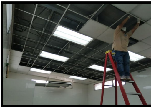
Ilustración 11. Adecuaciones en la Morgue Judicial de Darién
