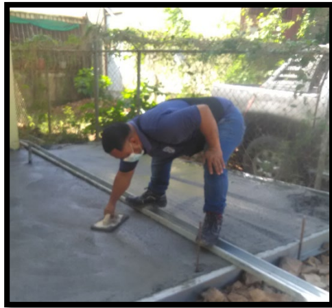
Ilustración 10. Losa para instalación de Manejadoras en Herrera
